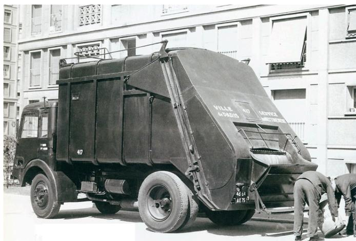
*Fig. 5 : Benne à fonctionnement en continu (chargement et tassement), Paris, 1953. La trémie, c'est-à-dire la partie arrière dans laquelle l'éboueur déverse les déchets, est abaissée pour faciliter ses gestes*
