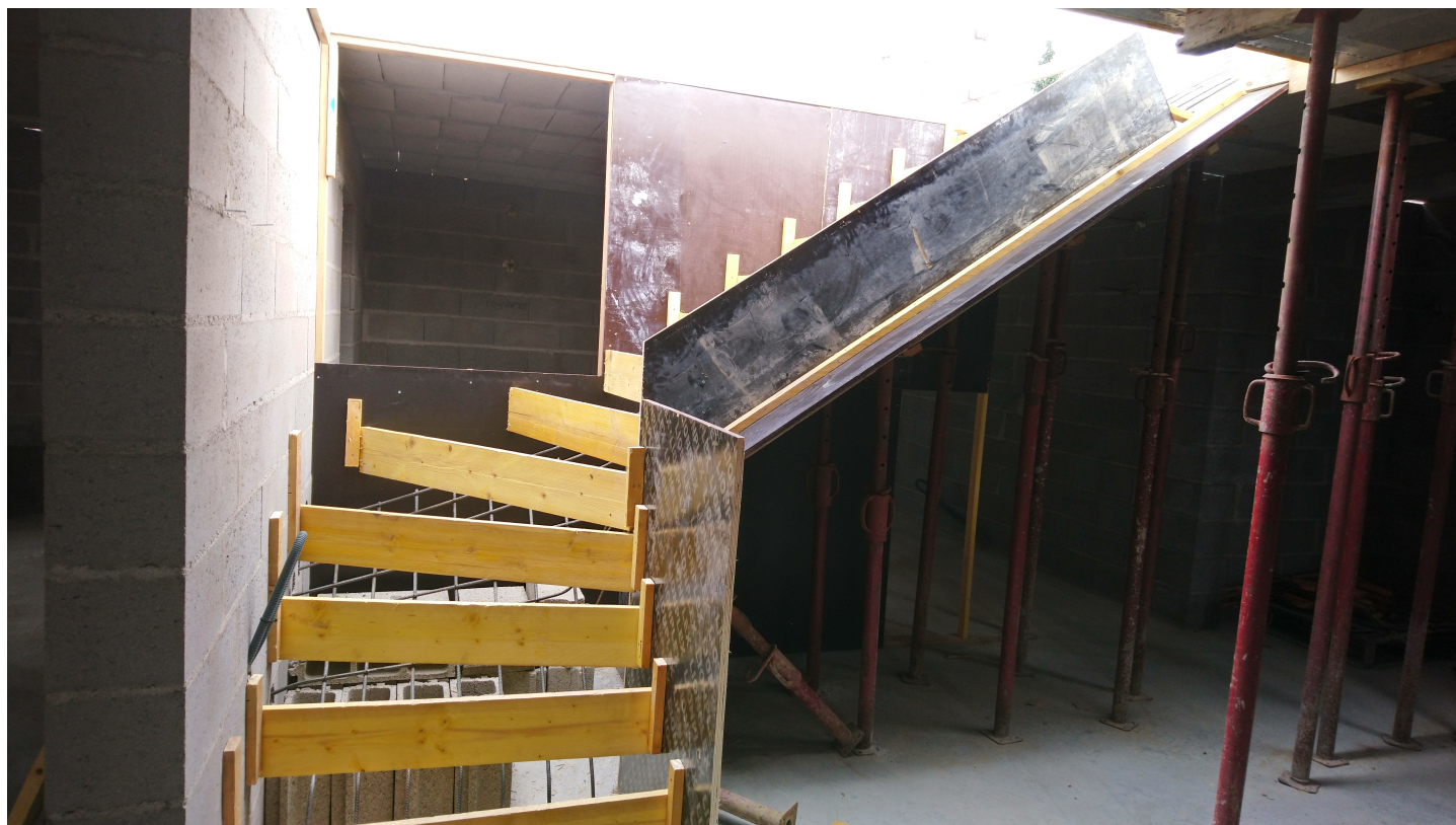
Figure 2.18. Coffrage d'un escalier
