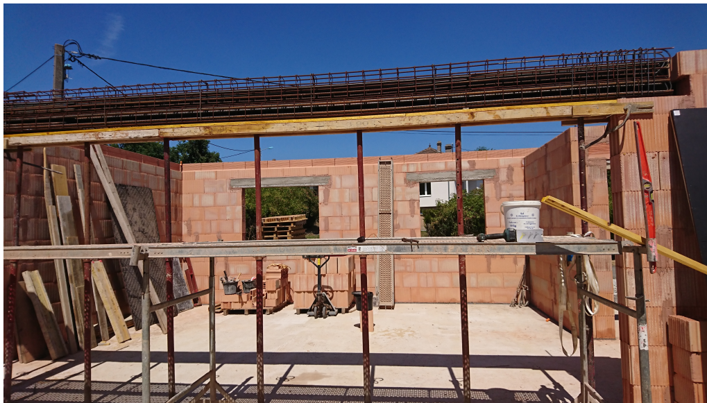
Figure 1.9. Coffrage d'un linteau
