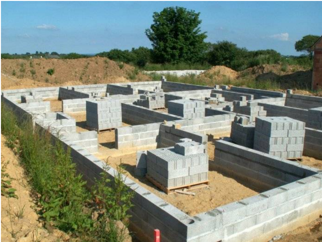
Figure 1.4. Construction du soubassement
