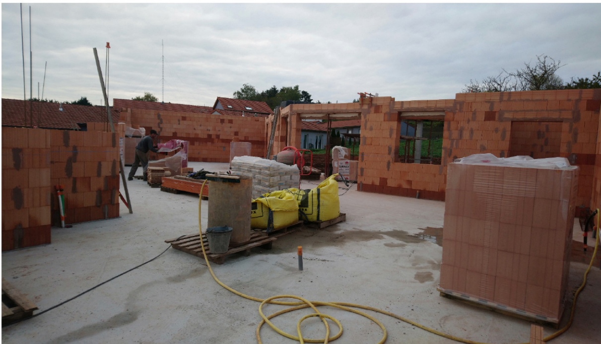
Figure 2.22. Le tuyau gris enfoncé dans la dalle de béton et relevé est la préparation du travail de plombier par le maçon, sa part d'aide. Il doit ainsi avoir une connaissance fine de ce que le plombier va faire.
