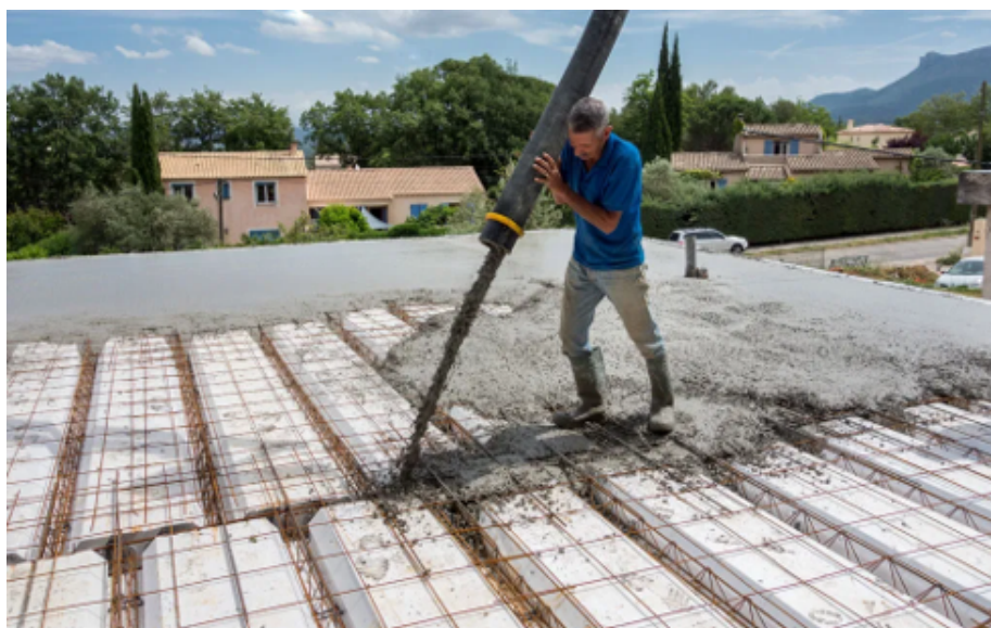
Figure 1.7. Coulage de la dalle
