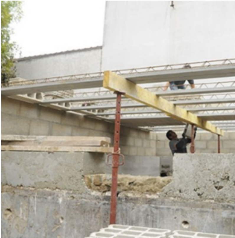
Figure 1.5. Pose, écartement et étayage des poutrelles
