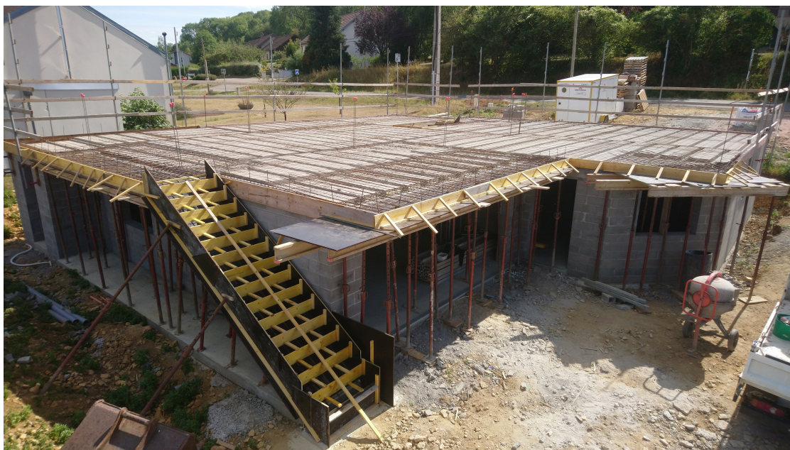
Figure 1.6. Coffrage et ferrailage
