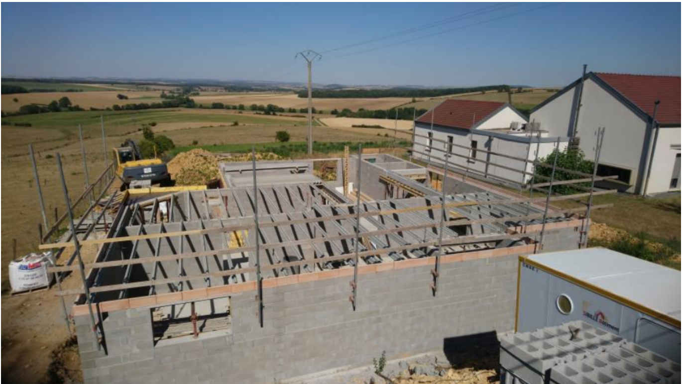
Figure 3.25. Ici, Les garde corps sont posés, mais pas le filet en dessous des poutrelles.
