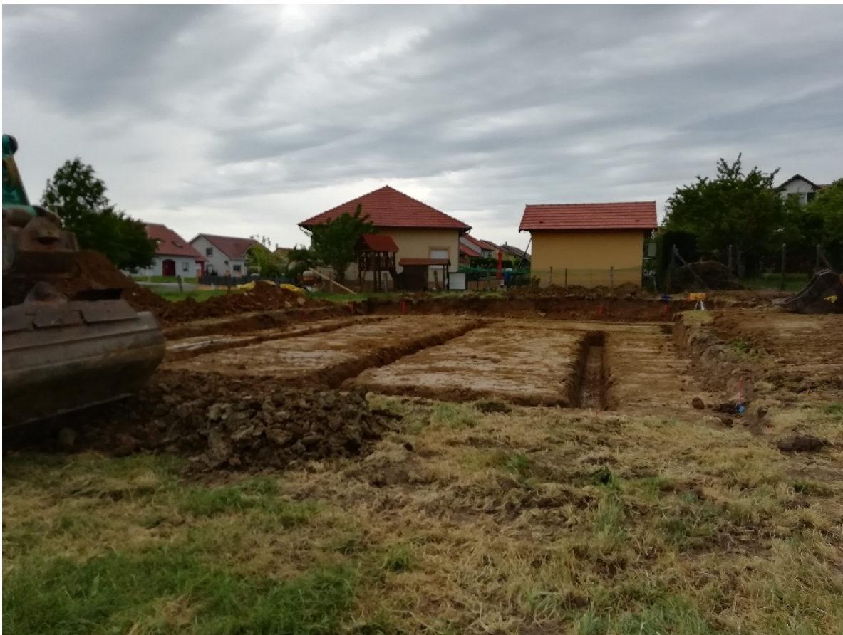
Figure 1.3. Terrassement d'un terrain à bâtir
