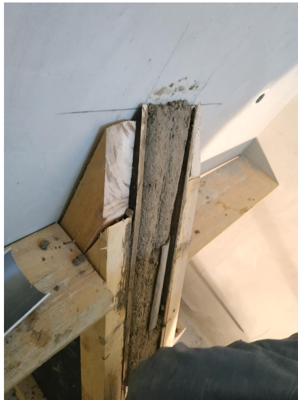
Figure 2.14. Tuyau PVC coupé en deux pour arrondir une nervure
